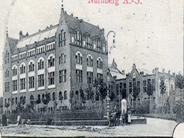
Beamtenhaus der vereinigten Maschinenfabrik Augsburg und Maschinenbaugesellschaft Nürnberg A.-G.
