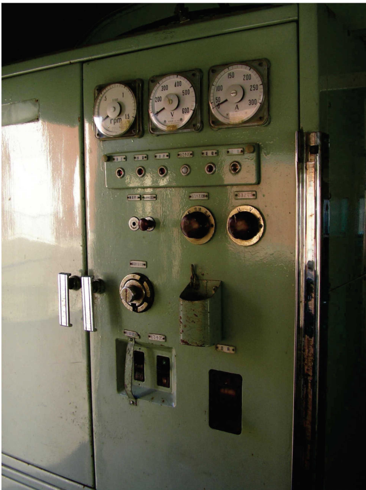
“Painel de controle analógico para gerador (Créditos: Wikimedia Commons / CC BY-SA 3.0).”
